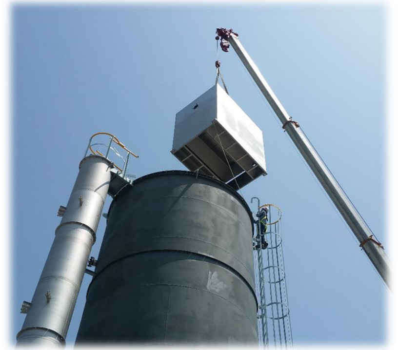
EGSB 상부에 Settler 설치 모습
